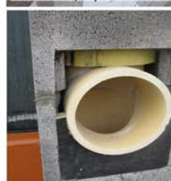
16-osadenie, zalepenie, presietkovanie izolácie sopúchu
