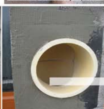
16-osadenie, zalepenie, presietkovanie izolácie sopúchu
