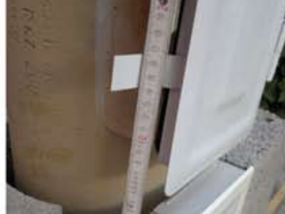
16-osadenie, zalepenie, presietkovanie izolácie sopúchu
