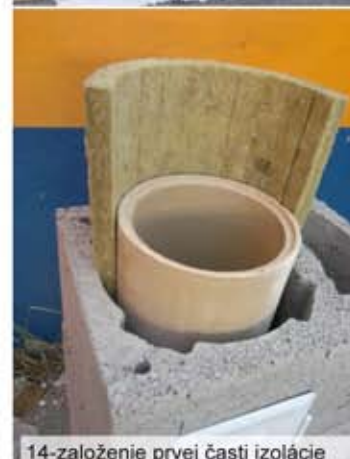
14-založenie prvej časti izolácie
